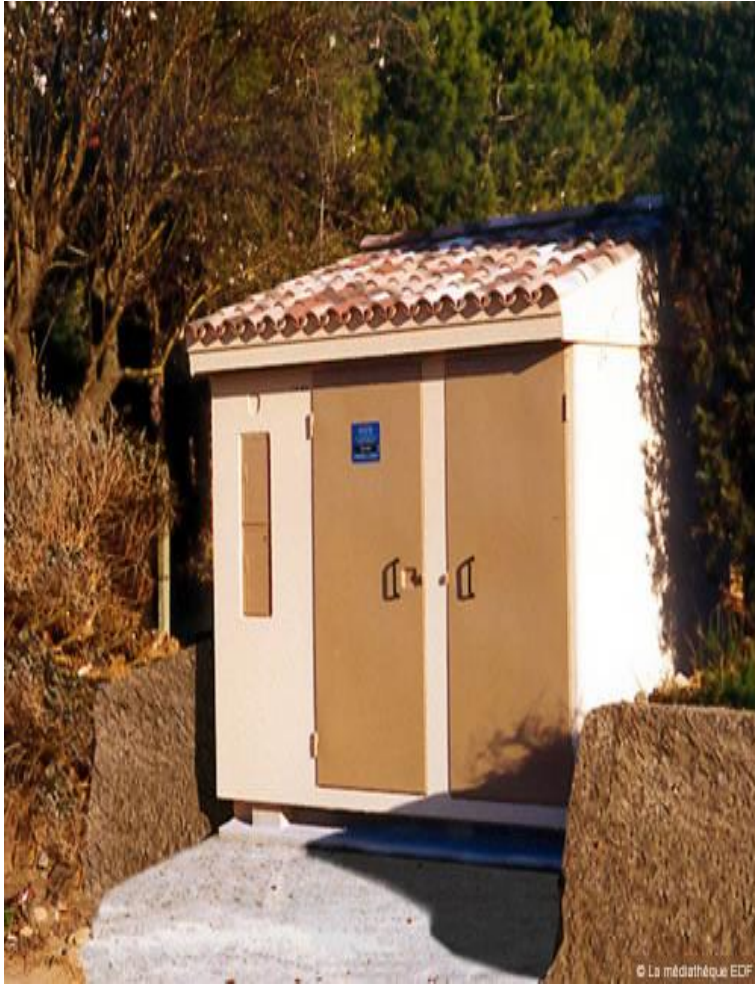
Poste de transformation HTA/BT maçonné (vue d'extérieur et d'intérieur)
