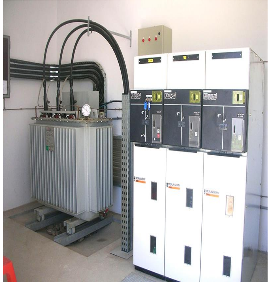
Poste de transformation HTA/BT maçonné (vue d'extérieur et d'intérieur)
